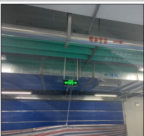
图4-2 地下车库机械供排风系统
