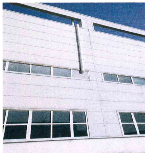
脉冲收尘器配置 15m 排气筒
