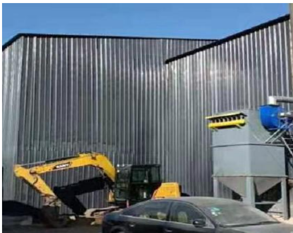
图 4-1 全封闭搅拌车间、原料库
