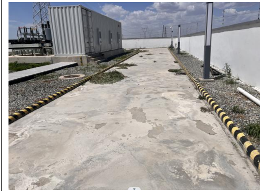
厂区道路硬化
